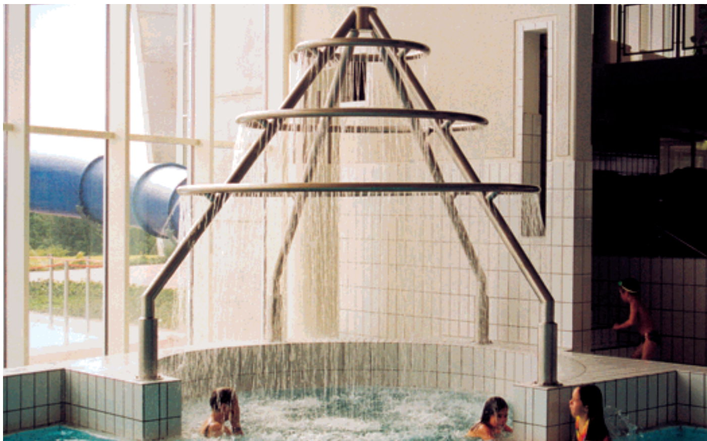
Regenpyramide Typ Goch aus Edelstahl, 4-beinig, mit 3 unterschiedlich großen, wasserführenden Ringen. Wasserbedarf ca. 150 m 3 /h.
